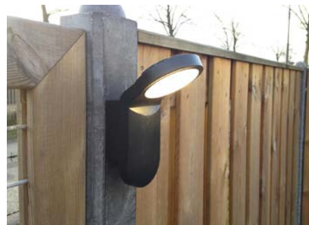
Betonpaal met lichtleiding
